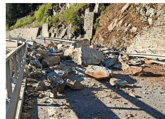
Mehrere Kubikmeter Felsen verschütteten die Strasse zwischen Le Prese und Miralago. (ZVG)
